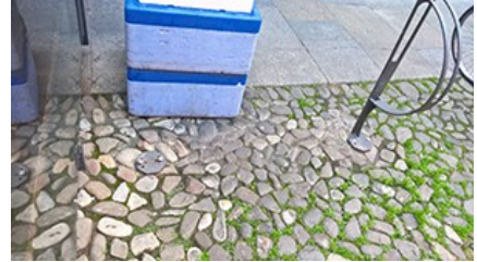
Via Selmi 20 - 1 portabici - 2 posti bici
